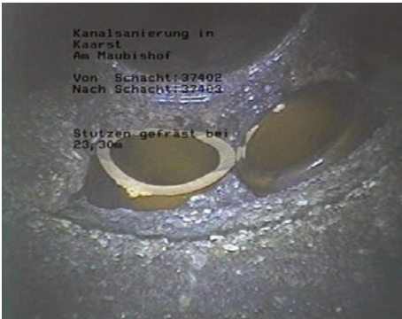
Sanierung Doppelstutzen, Stutzen vorher (l.) und nachher | Fotos: Katec Kanaltechnik Müller & Wahl GmbH
