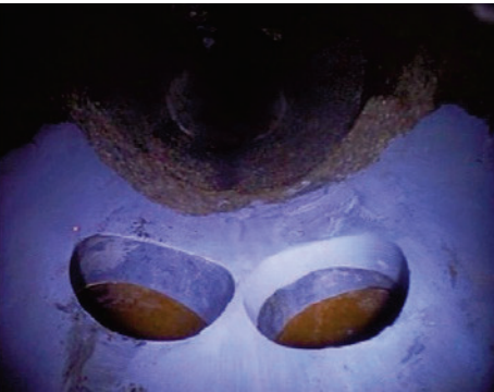
Sanierung Doppelstutzen, Stutzen vorher (l.) und nachher | Fotos: Katec Kanaltechnik Müller & Wahl GmbH
