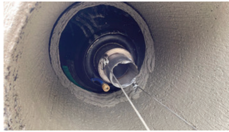
Reprofilierung vor Linereinbau | Foto: SKT / Hermes Technologie GmbH & Co. KG
