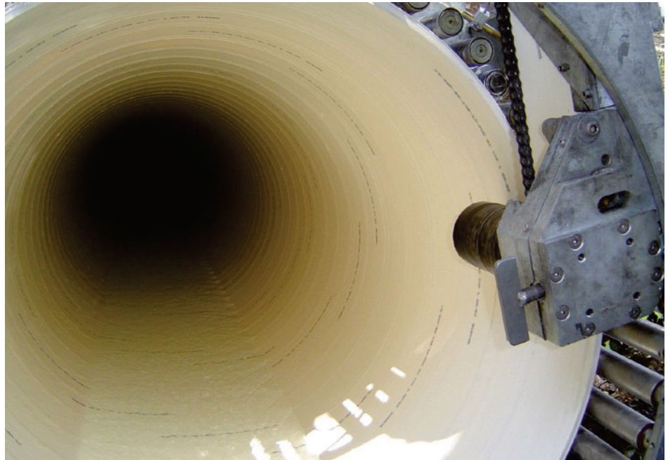
Wickelrohrverfahren | Foto: Geiger Kanaltechnik GmbH & Co. KG
